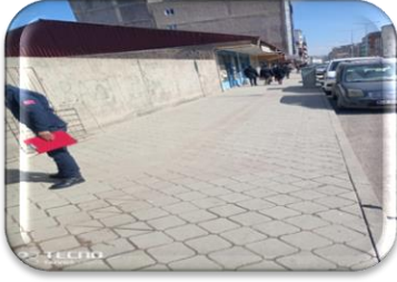
Yaya Geçiş Yolları Kontrolleri.
